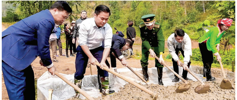
Bộ đội cùng bà con thôn Nậm Sò làm đường xây dựng nông thôn mới
