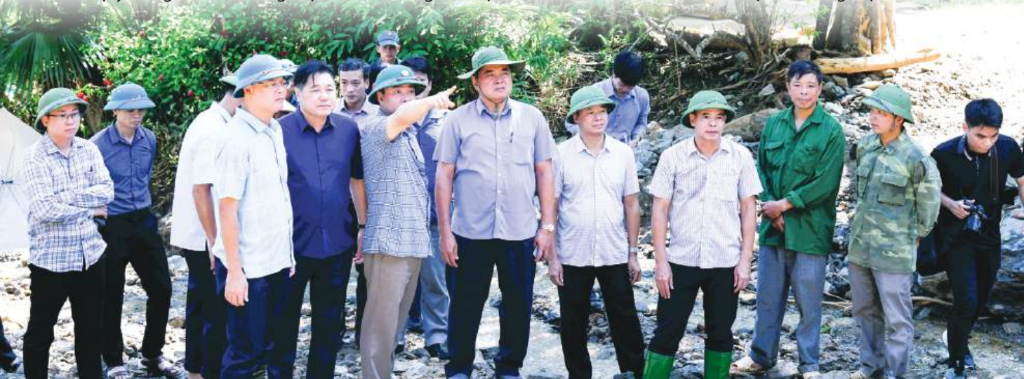
Thứ trưởng Trần Thanh Nam, ông Hoàng Gia Long - Phó Chủ tịch UBND tỉnh Hà Giang đi khảo sát thực tế khu vực sạt lở
