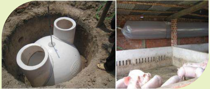
Xây bể khí sinh học composite và túi khí dự trữ
