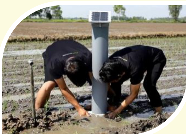
Lắp đặt ống cảm biến canh tác ướt - khô xen kẽ trên ruộng lúa
