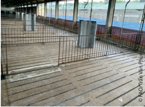
Hình 26. Kiểu nền sàn (1) và nền bê tông (2) để nuôi lợn thịt
