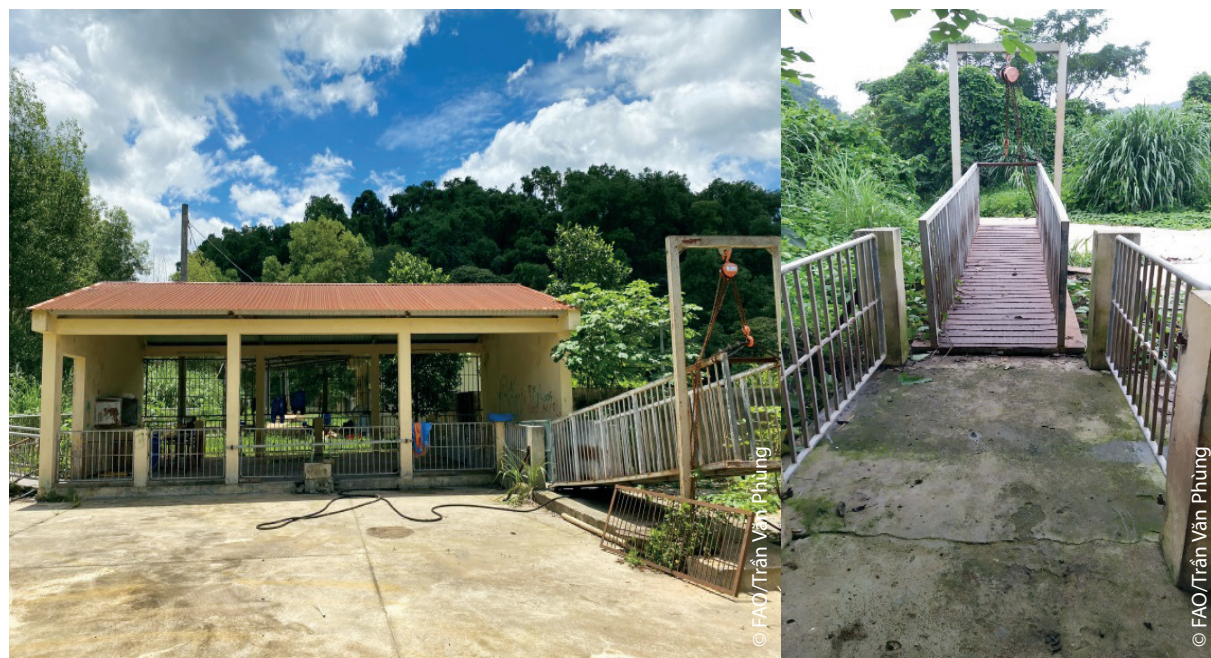
Hình 33. Nhà và cầu xuất bán lợn
