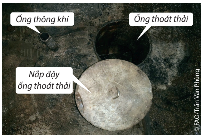
Hình 9. Đáy hầm chứa chất thải
