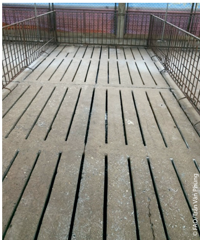
Hình 13. Sàn chuồng làm bằng tấm đan bê tông
