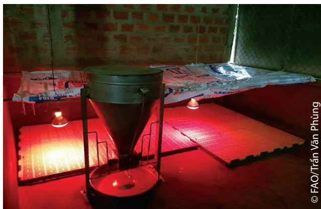
Hình 107. Lắp đặt bóng đèn và tấm pallet
