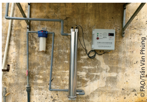
Hình 14. Hệ thống diệt khuẩn làm sạch nước ở đầu dây chuồng nuôi
