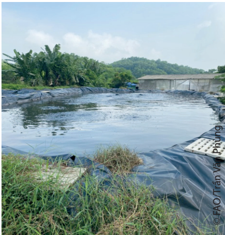
Hình 43. Bể sục khí
