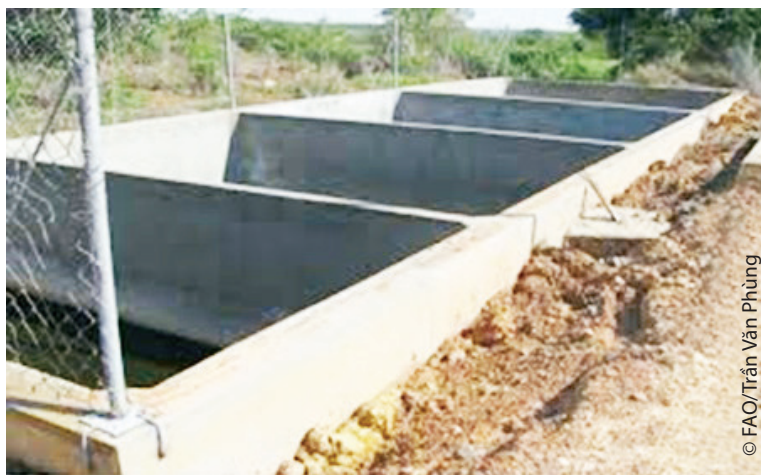
Hình 40. Bể thu gom chất thải chăn nuôi lợn
