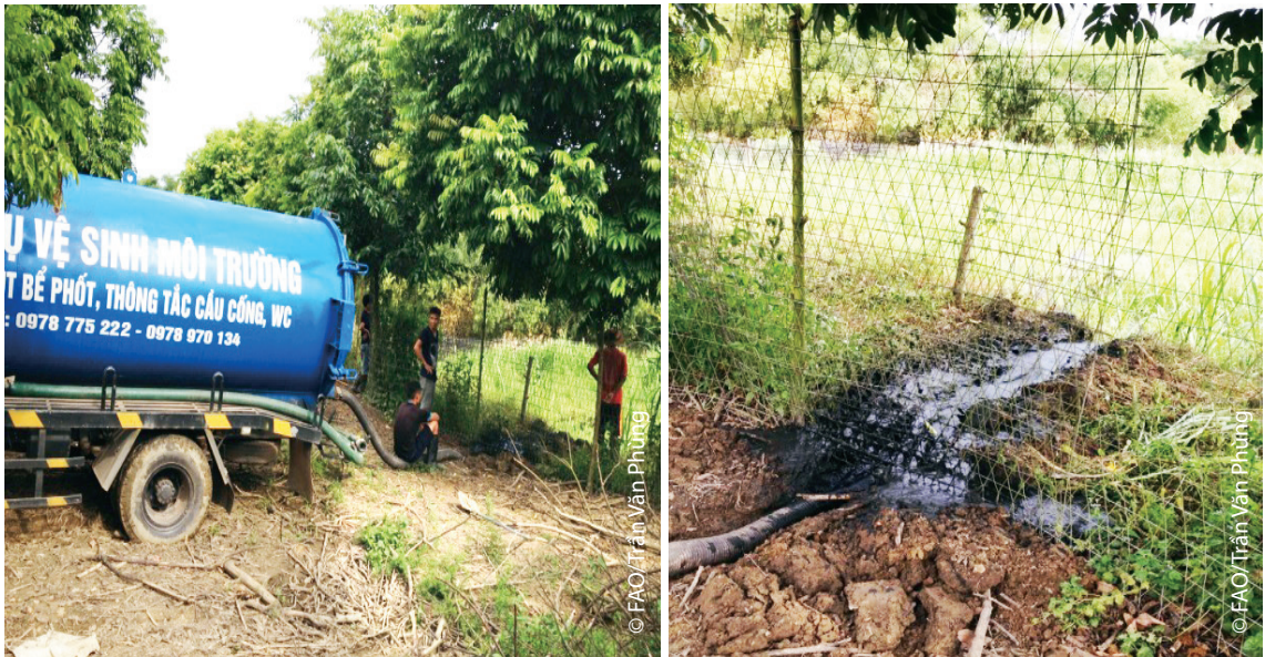
Hình 47. Hút và nạo vét cặn bể biogas
