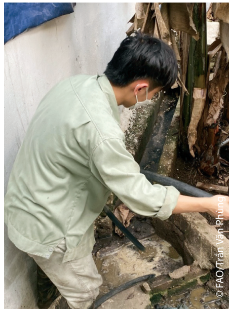
Hình 42. Sử dụng cây sào để khuấy đảo phá váng bể biogas
