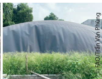
(3) Bể phủ bạt HDPE
