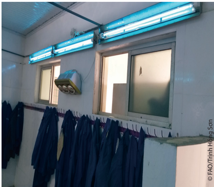
Hình 20. Khử trùng quần áo bảo hộ bằng tia UV
