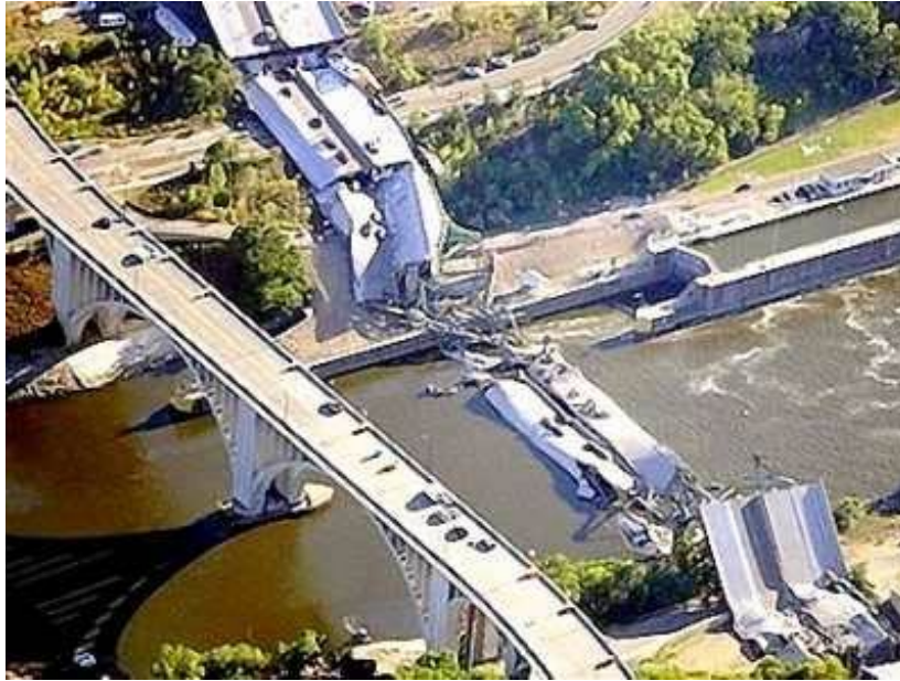
Hình 2. Cầu bắc qua sông Missisipi (Hoa Kỳ) bị sập ngày 2/8/2007 do sự phá hủy lâu ngày của phân chim bồ câu
