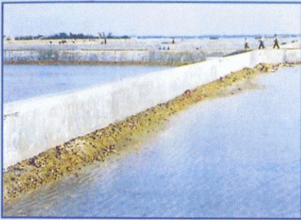
Hệ thống ao được bê tông hóa toàn bộ
