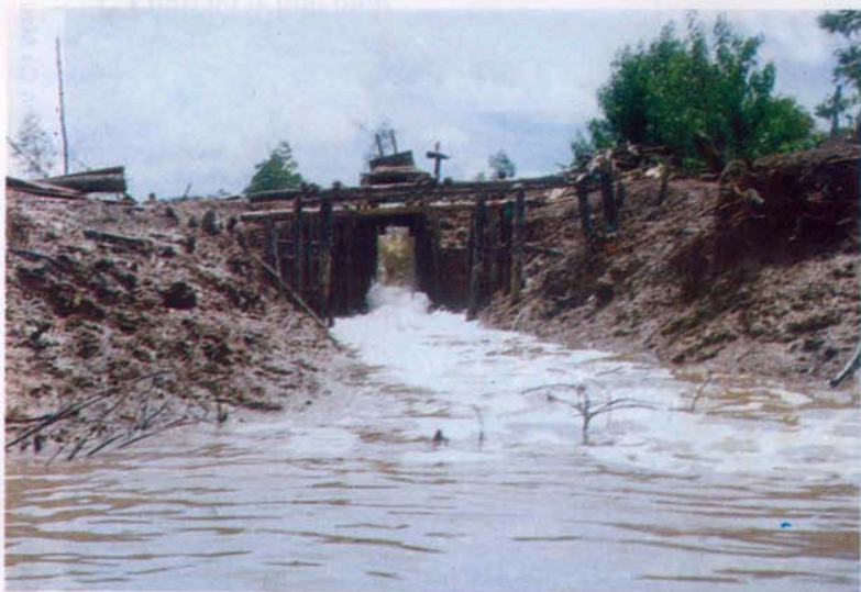
Cổng lấy nước và sỏ bắt tôm (tháo nước ra kênh khí nước triều dâng) LNT 184 - Cà Mau
