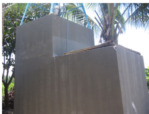
► Hệ thống lọc nước đơn giản
