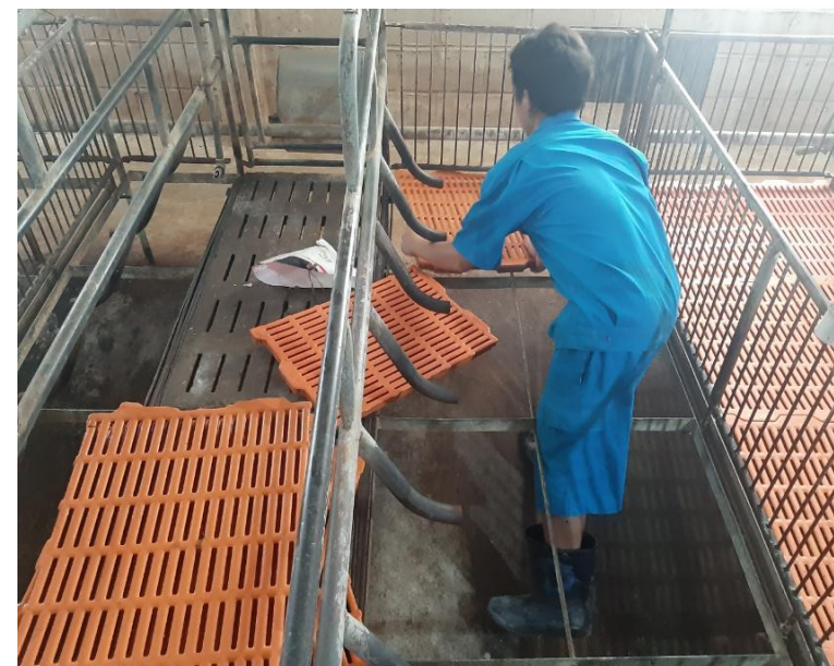
Lắp đặt thiết bị trở lại
