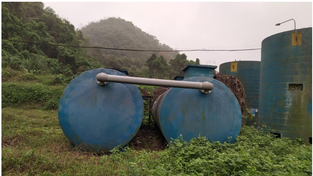
Hình 134. Bể xử lý chất thải chăn nuôi
