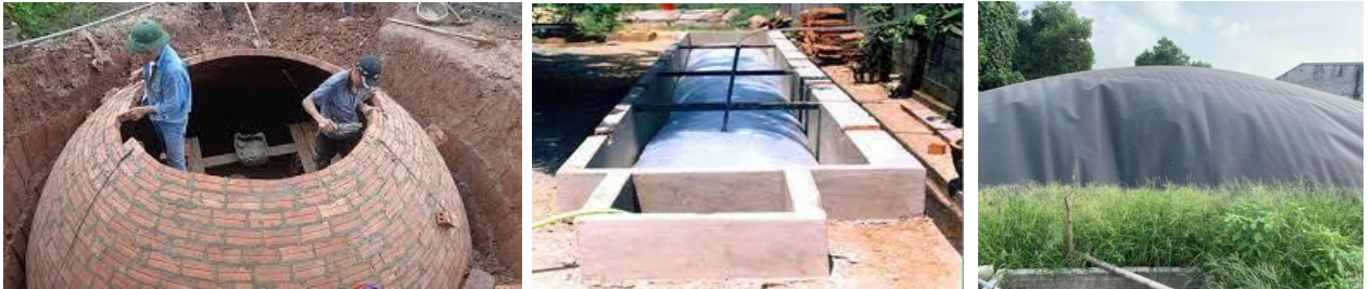
Hình 98. Các loại bể biogas
