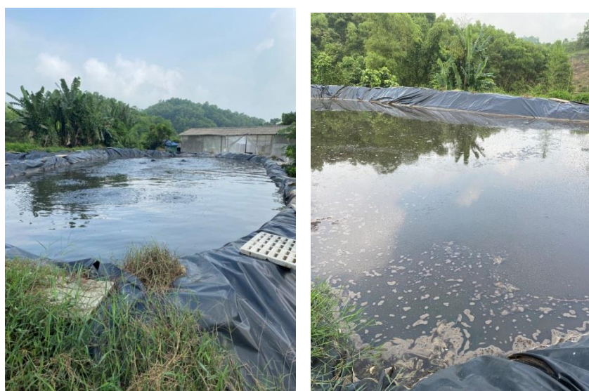
Hình 100. Bể sục khí và bể sinh học (Trần Văn Phùng)
