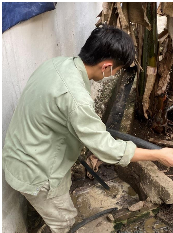
Hình 99. Sử dụng cây sào để khuấy đảo phá váng bể biogas (Trần Văn Phùng)
