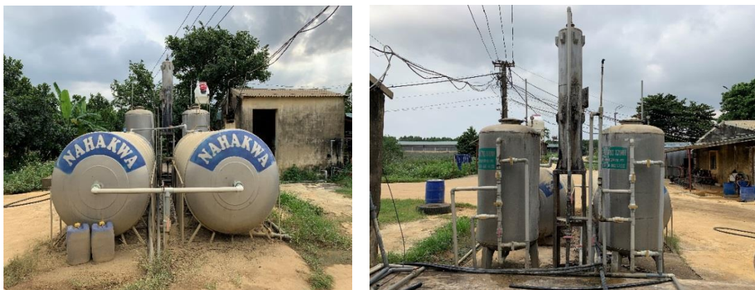
Hình 2. Hệ thống lọc, xử lý nước trước khi sử dụng chăn nuôi lợn (Trịnh Hồng Sơn)
