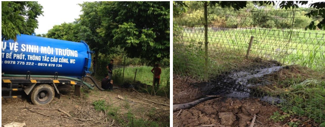
Hình 103. Hút và nạo vét cặn bể biogas (Trần Văn Phùng)
