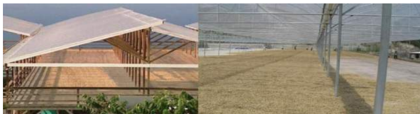
(a) Nhà lợp tôn
